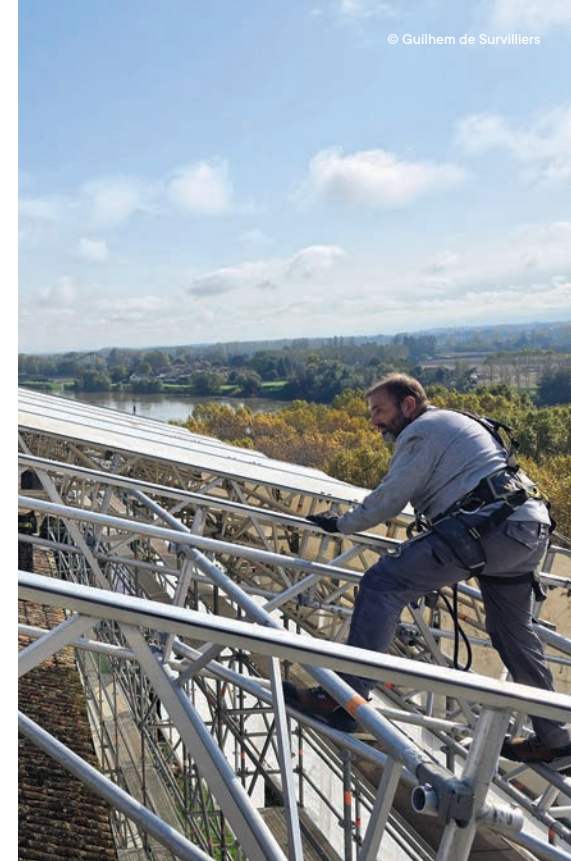
Restauration du château des Quatre SOS à La Réole (Gironde)
