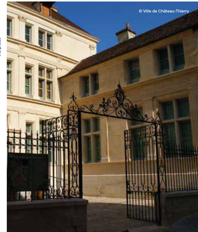
La maison natale de Jean de La Fontaine à Château-Thierry (Aisne), devenue musée, doit être restaurée et aménagée.
